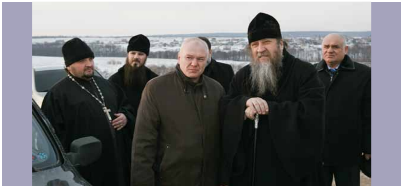
В Алферьевке на строительстве храма прп. Пимена Угрешского. Слева от владыки храмоздатель О.Л. Шаповал. 10 января 2012 г.
